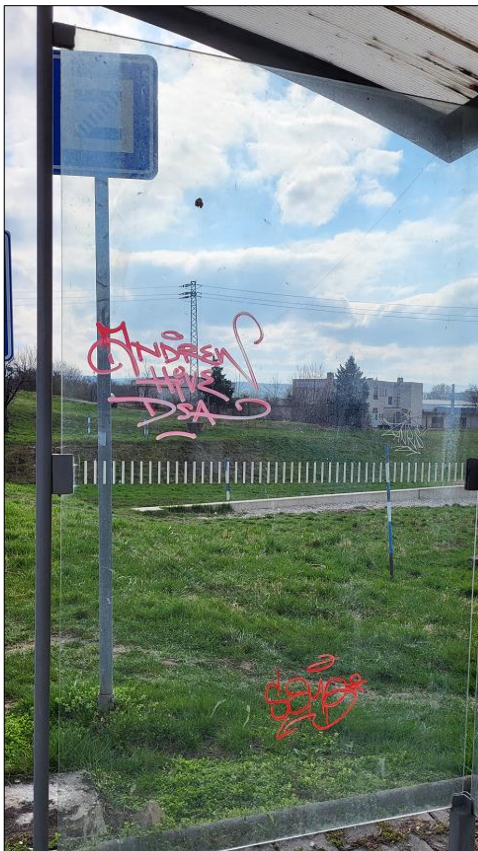
Obr. č.4: Popsaná skleněná bočnice autobusové zastávky, ul. Šumická, v r. 2023 i 2024
